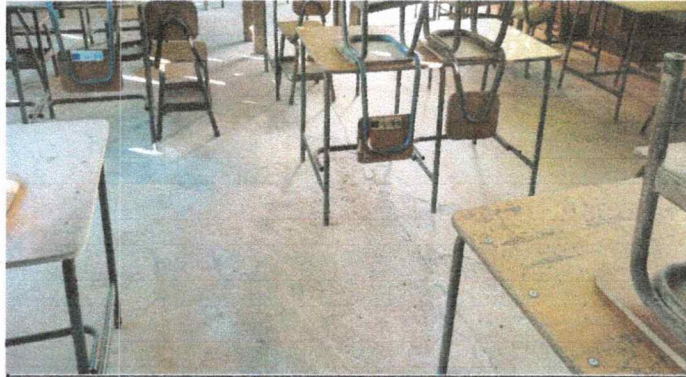
Foto 7. Se necesita sustitucion del piso, ya que este se encuentra descascarado y agrietado.
