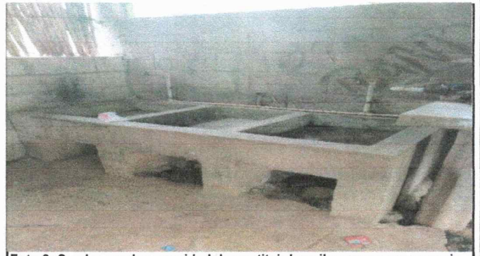
Foto 6: Se observa la necesidad de sustituir las pilas, ya que por ser piso de tierra se han hundido y ya estan deterioradas.
